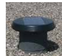
Installation sur toit terrasse
